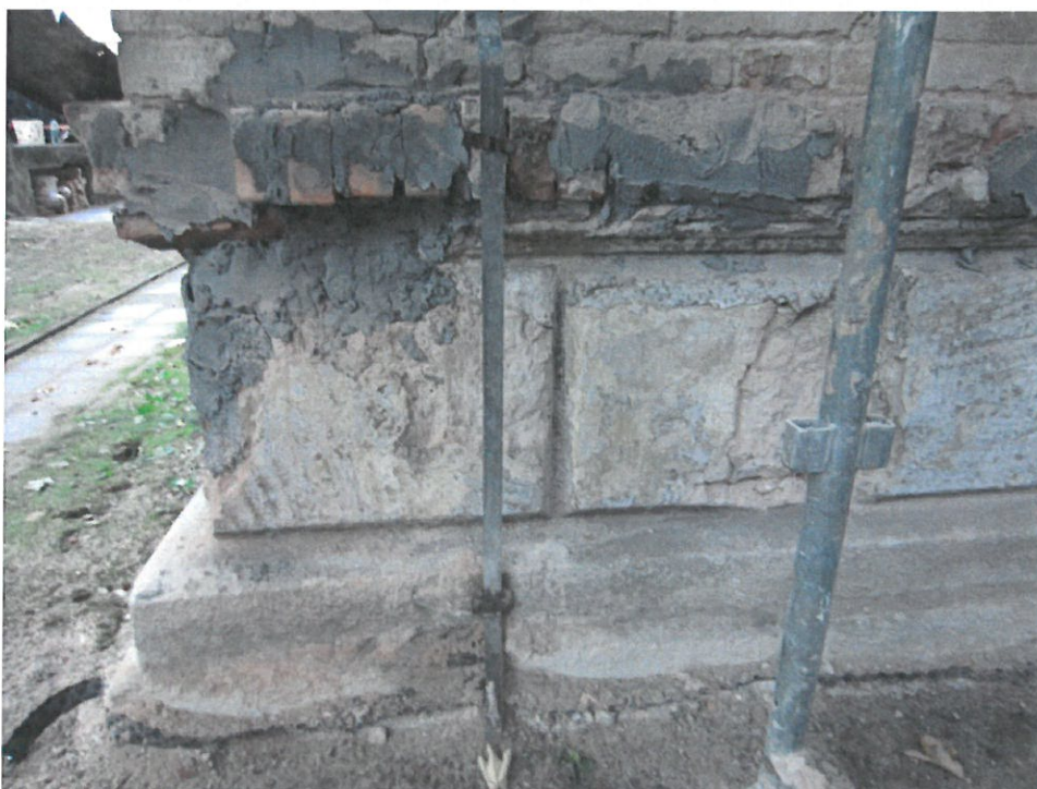
Fot.5. Fragment cokołu kamiennego na narożu ryzalitu na ścianie północnej budynku, po usunięciu cementowych nawarstwień i wtórnych uzupełnień.
